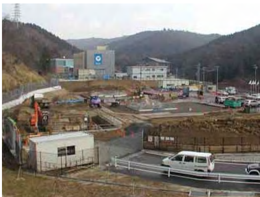
瑞浪超深地層研究所の研究坑道掘削現場風景(2004.2.12)
